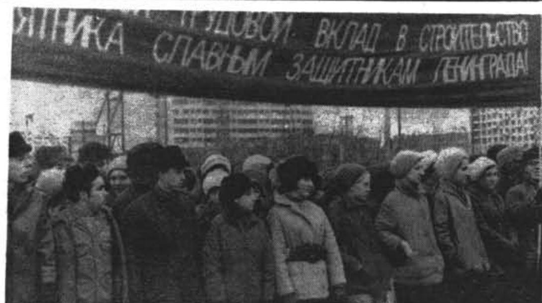
Студенты ЛИТМО на строительстве памятника защитникам Ленинграда.
