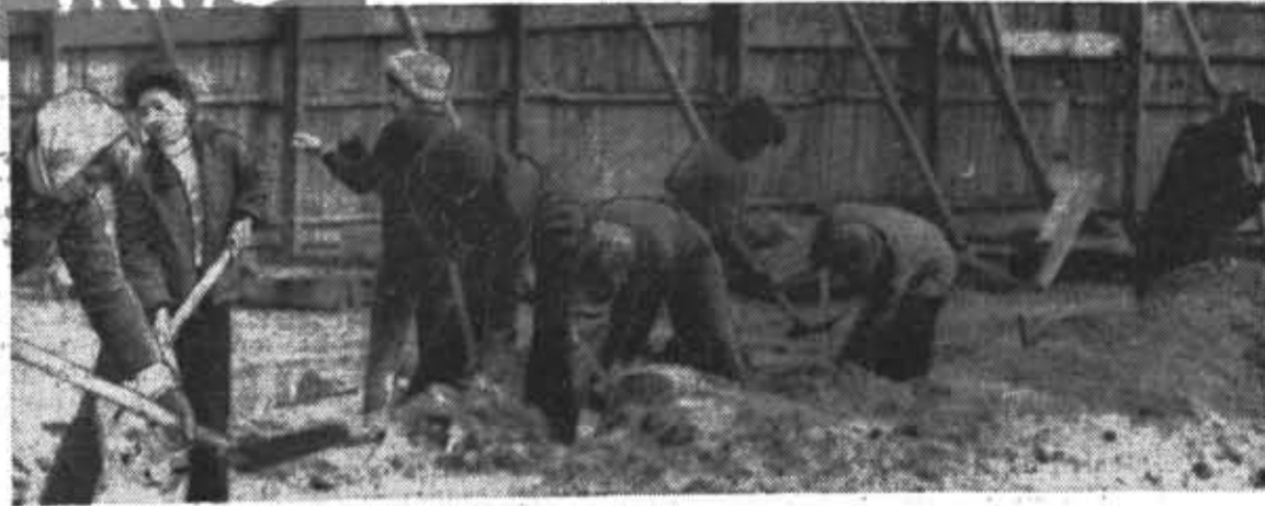
Литмонаты на строительстве памятника героическим защитникам Ленинграда.
