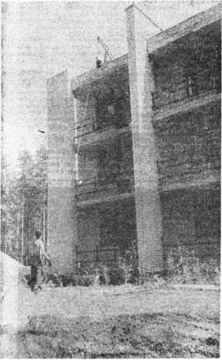
НА СТРОИТЕЛЬСТВЕ спортивно-оздоровительного лагеря института в Ягодном.
