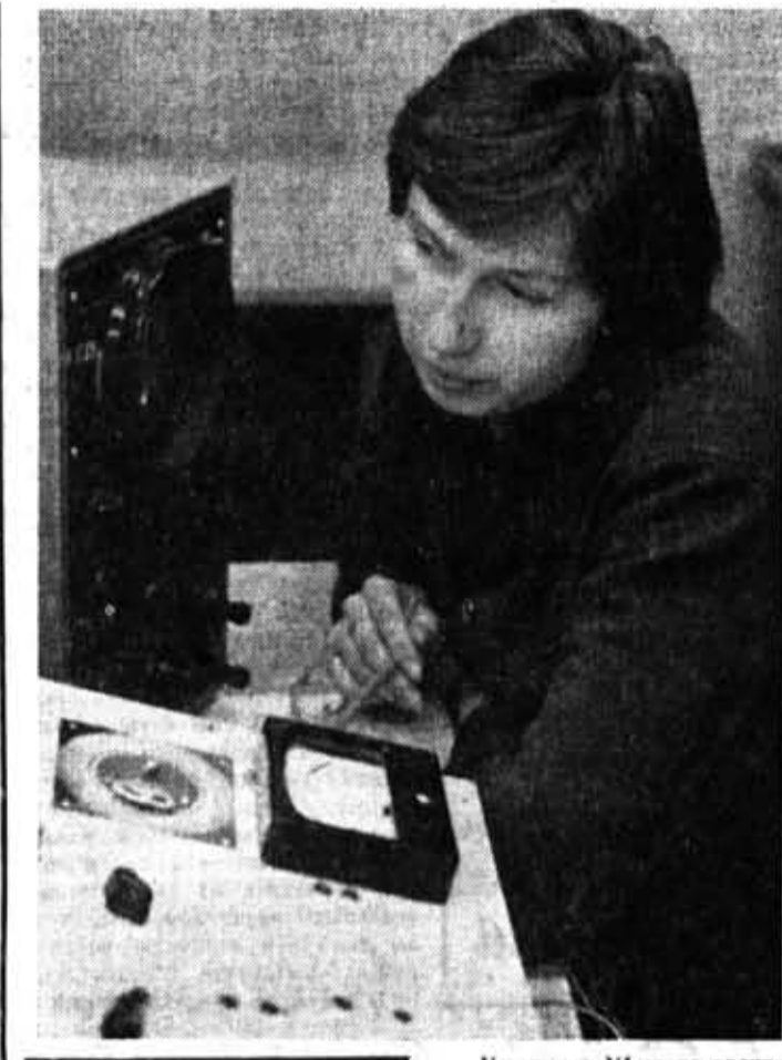
Участница VI слета отличников студентка 415-й группы Мария Горбачева проводит исследование следящей системы с асинхронным двигателем. Фото студента 431-й группы Игоря Манделевского.
