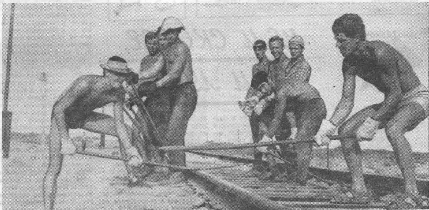
На снимке: литмонавты на строительстве трассы Гурьев — Астрахань.
