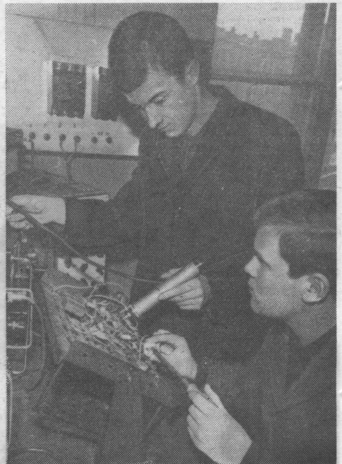
На снимке: авторы статьи исследуют диэлектрический метод влагометрии почвы.
