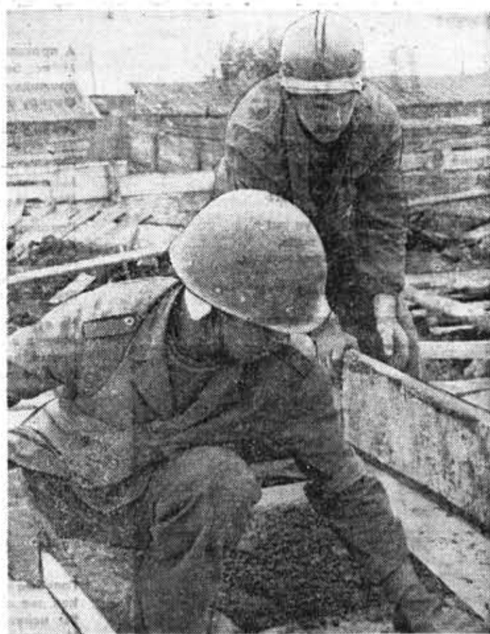
Из фотолетописей ССО. Сегодня мы бетонщики... (Отряд «Квант»).
