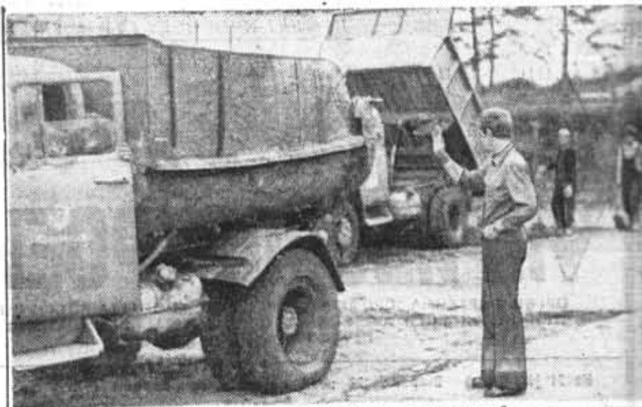
Из фотолетписи ССО. На дорожных работах.
