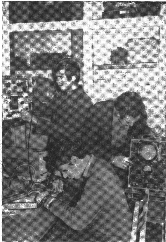
Будни СНО. На кафедре автоматики и телемеханики под научным руководством доцента В. Н. Дроздова студенты Юрий Арсеньев, Александр Шепсенов и Александр Богачев работают над устройством для фазовой автоподстройки частоты. Фото З. Саниной.
