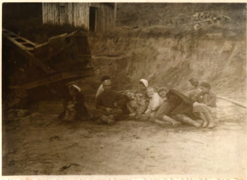
В котловане после ночной смены
