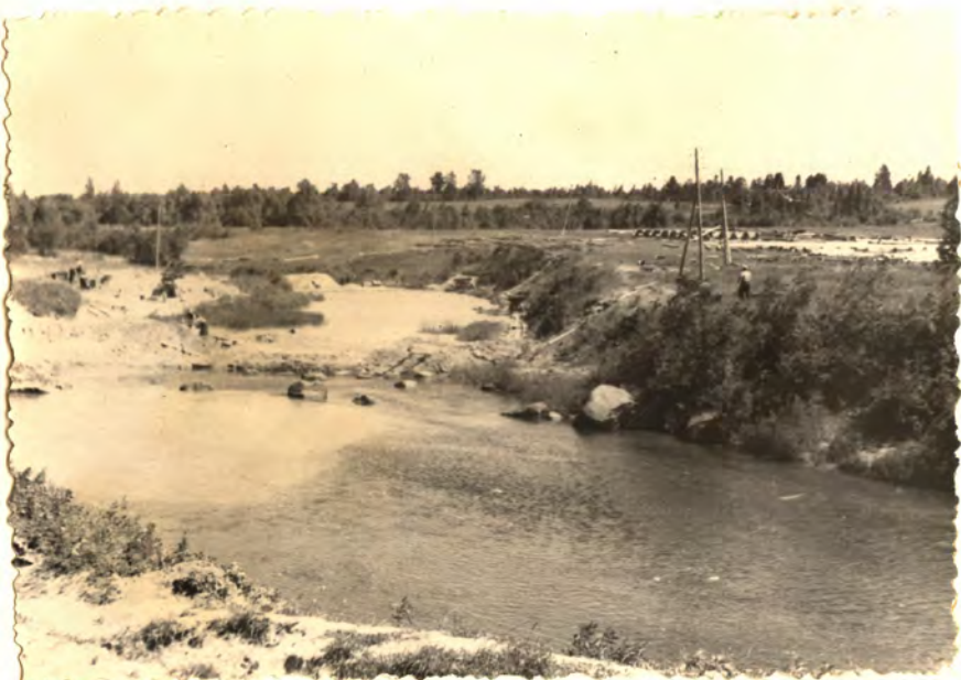
Перед началом работ
